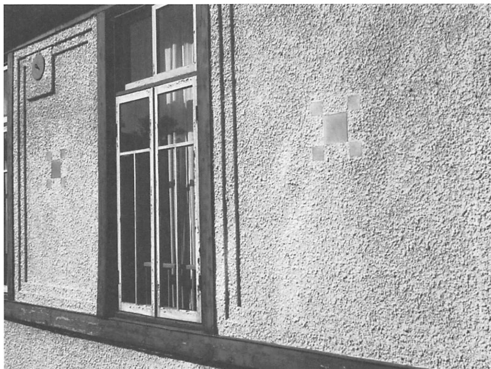
50 1号室外側壁面に貼り付けられた装飾タイル。
