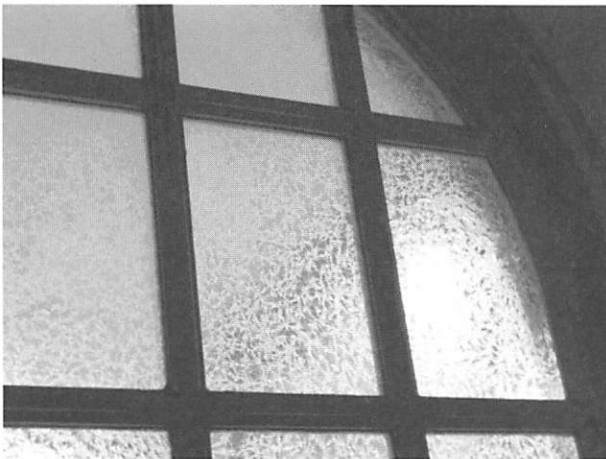
10 窓ガラスを反対側から見たところ、創建当時のもの。 会館建物の窓に使われているガラスは殆どが創建当時のもの。一部破損後に修理したものがあるが、創建時と同じものがなく、担当者は大変苦労したらしい。
