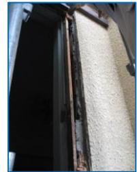
上げ下げ窓は、塗装が剥げ、窓枠が痩せ隙間があき、ガラスを止めるパテはほぼ脱落しガラスがはずれんばかりであった。木部飾り枠、軒天井等の塗装は剥げ、朽ちる寸前であった。この状況を放置して置くと雨水等の侵入により腐れが発生して会館は、大変な事になる。速やかな改修工事が必要となる。結果を、踏まえ実施計画をたてる
