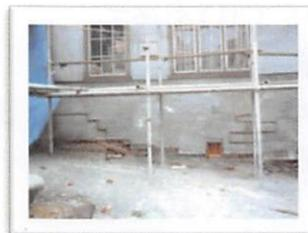
修繕のため、外壁を剥がし、新たに貼った板上に下地を塗ったところ、レンガタイルの場所が区切られている
