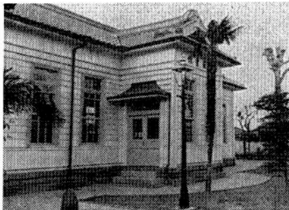
復元の改修工事が終わった旧金山図書館
